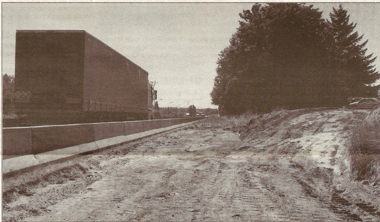
Attendu depuis près de 30 ans par les habitants du Vintué, le mur antibruit se dressera entre les pavillons et la Nationale d'ici février 2009.
